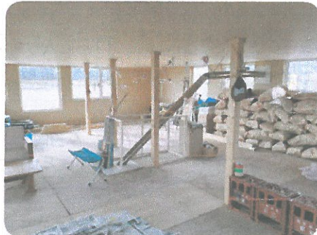
1Fの薪ストーブの煙突は2Fも温めて外へ出ます
