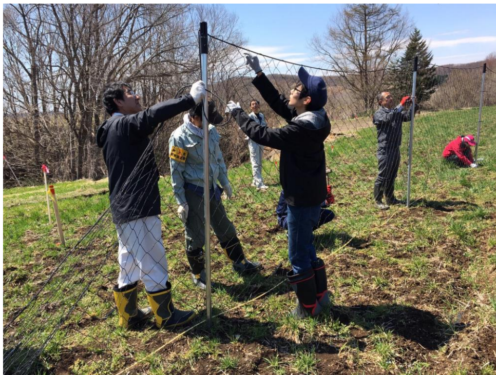
2019年5月4日 鹿侵入防止の柵(ネット)を設営しているところ
