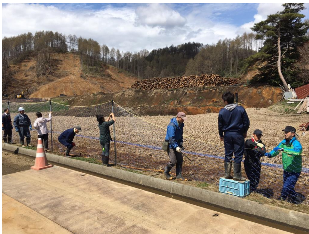
2019年5月5日 鹿侵入防止の柵(ネット)を設営しているところ
